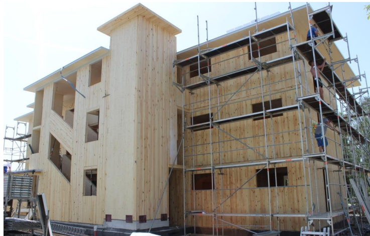
Abbildung 1: Nordwestseitige Ansicht des Wohnobjektes 1
